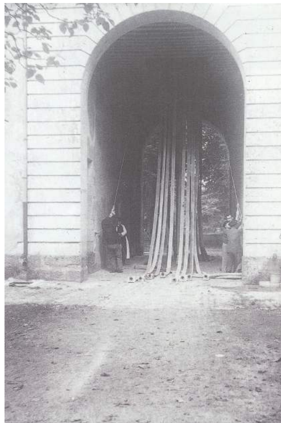
Vérification du système de pompes à eau anti-incendie
